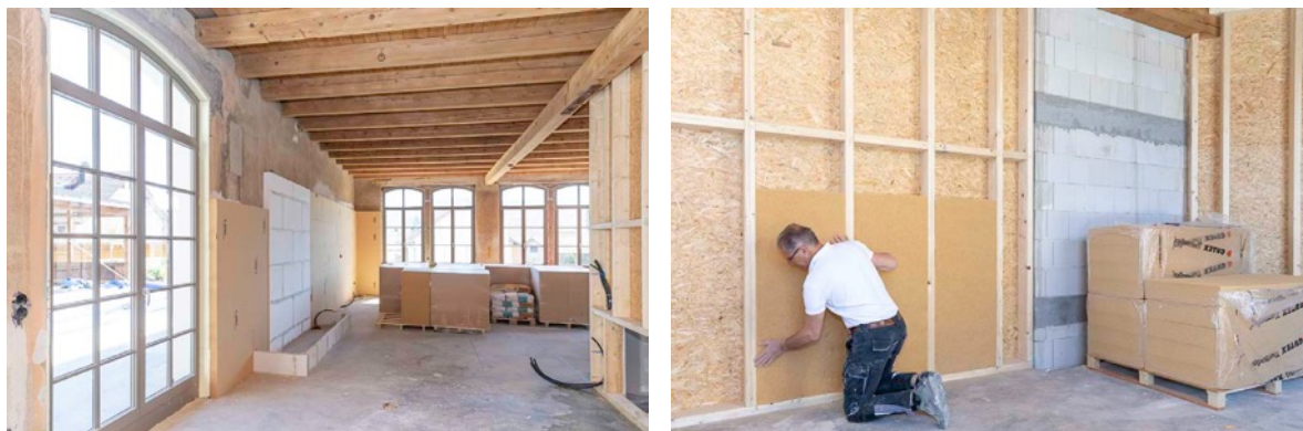
Links: Die Holzfaserdämmplatten GUTEX Thermoroom werden an der Bestandswand fixiert und mit einem Lehmputz verputzt. Rechts: Um Räume abzuteilen wurden zudem neue Holzständerwände eingezogen und mit GUTEX Thermoflex Dämmmatten ausgekleidet. Fotos: Martin Granacher.
