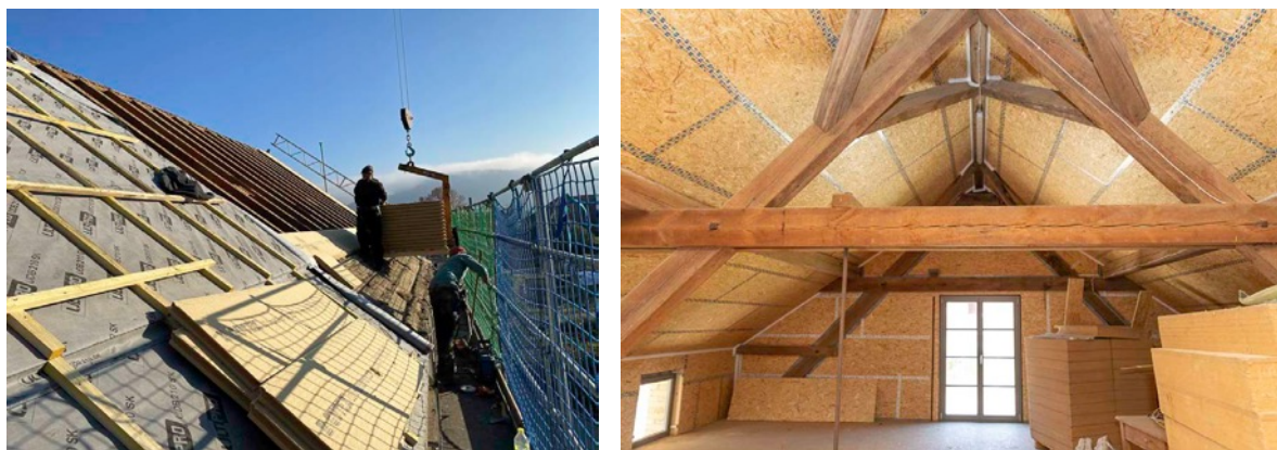
Links: Auf den Sparren liegt die Unterdeckplatte GUTEX Ultratherm. Rechts: Hinter den OSB-Platten dämmen GUTEX Thermoflex im Gefach – so wird das Dach sowohl vor Kälte als auch vor Hitze geschützt. Fotos: C. Tröndle, Martin Granacher.
